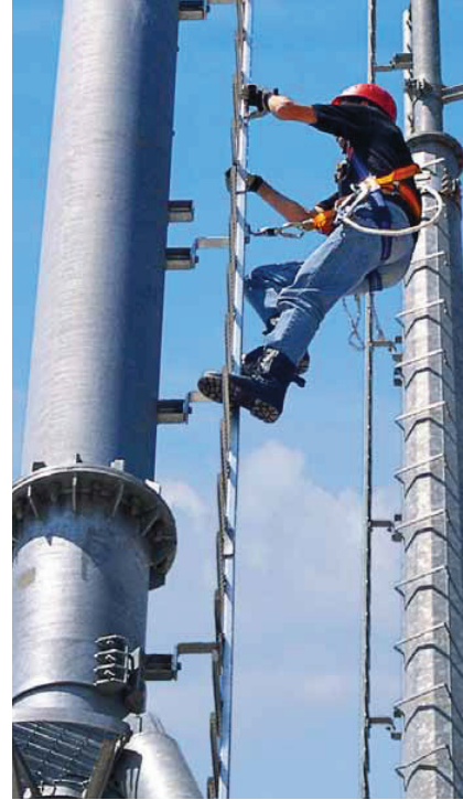
SKYTAC-Leiter an Mobilfunkmast. · SKYTAC ladder on a mobile phone mast.
